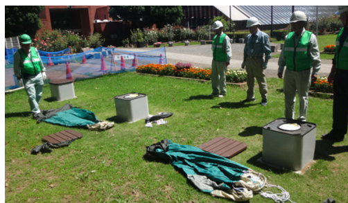
防災トイレの設置作業のようす
