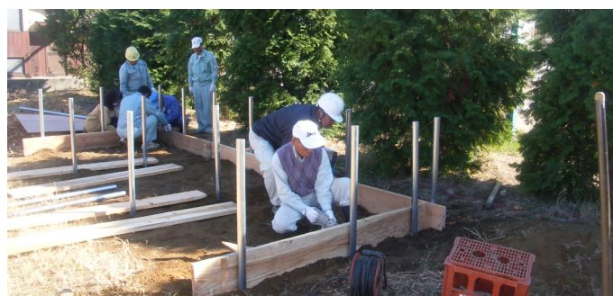
ヤード下部の枠取り付け作業
