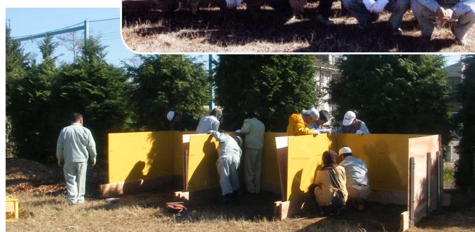
仕切り枠を取り付け作業
