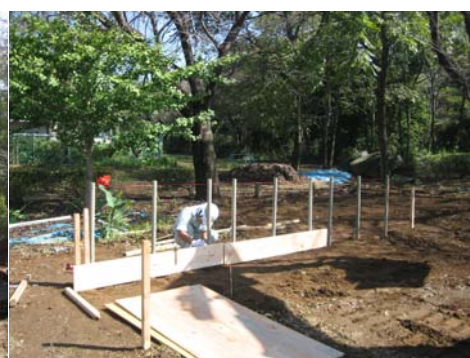
ヤード下部枠取り付け
