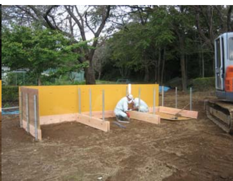
仕切り枠の取り付け
