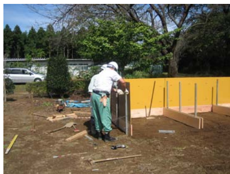
外枠の取り付け
