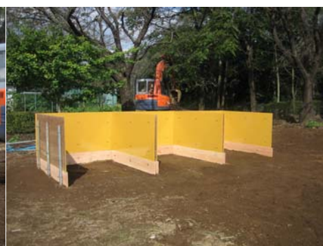
完成したヤード
