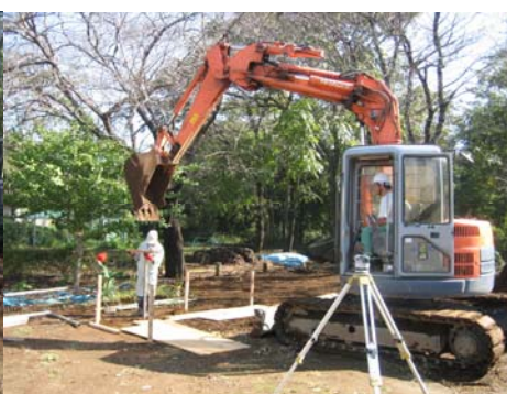
単管打ち込み
