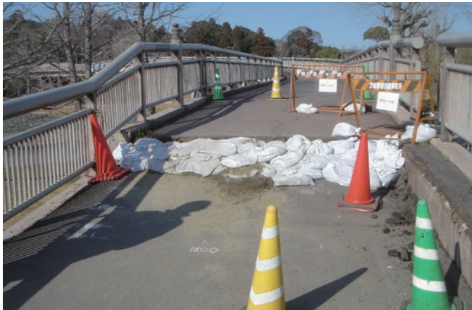
偕楽橋 千波湖降口（歩道滑落部応急対応・復旧）
