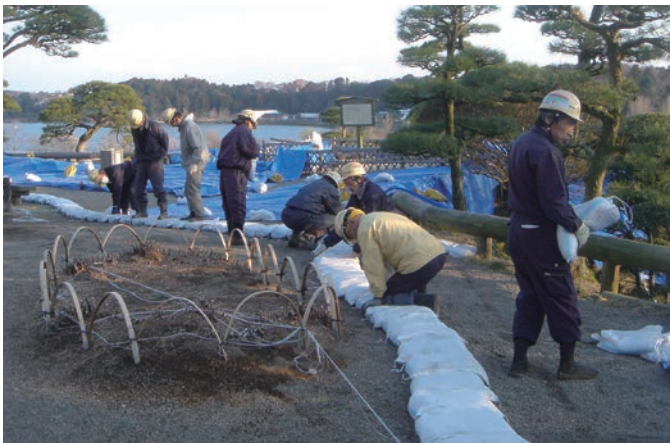
降雨による二次災害抑制作業状況
