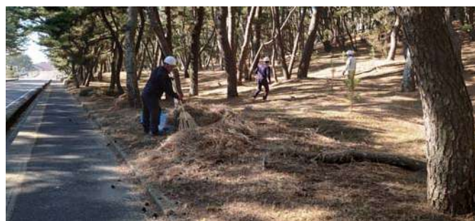
松葉や枯れ枝の収集撤去作業
