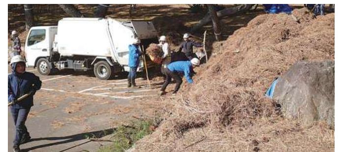
松葉や枯れ枝の収集撤去作業
